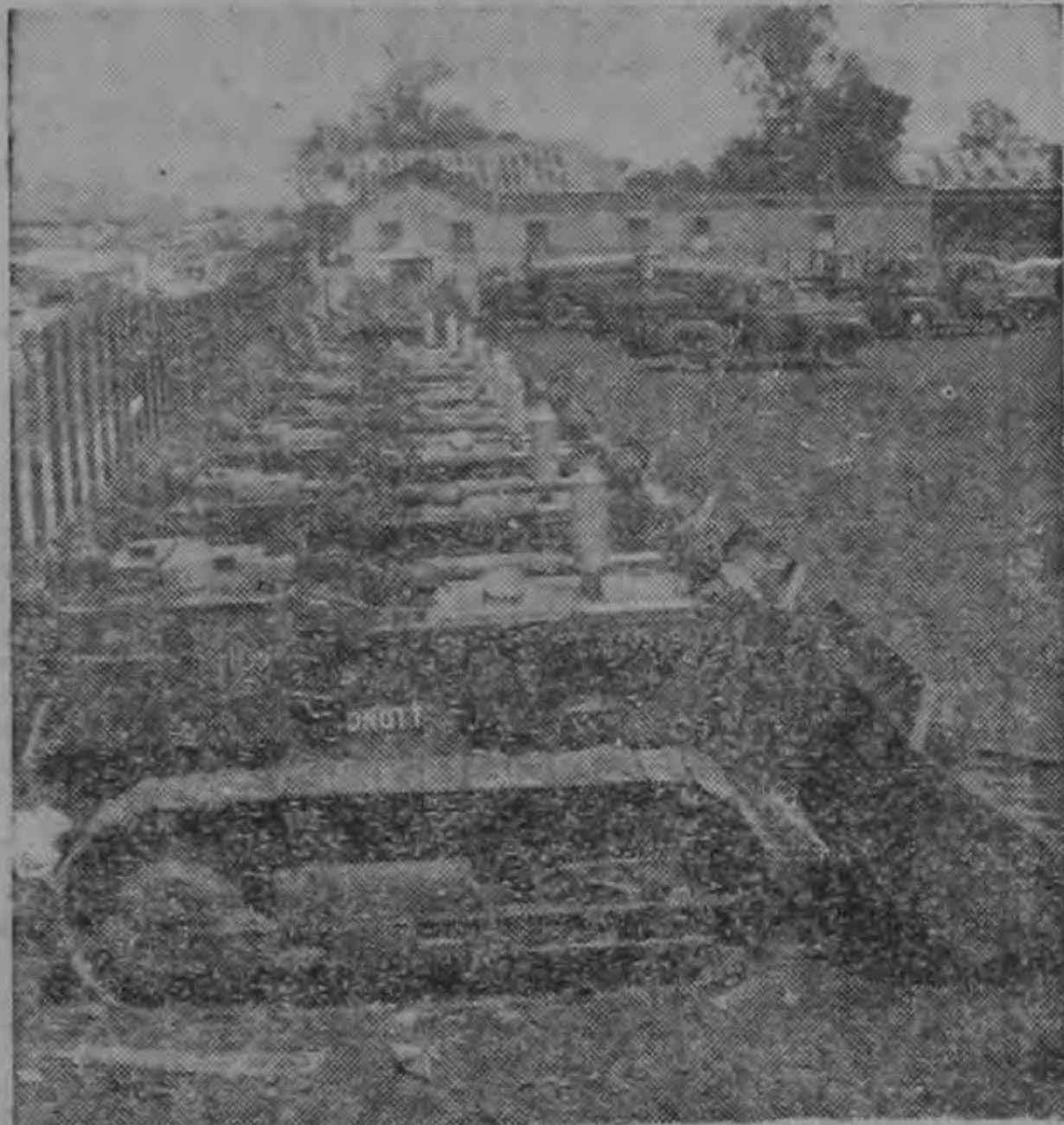
10 Tractores INTERNATIONAL TD-9 con Cargadores Drott
